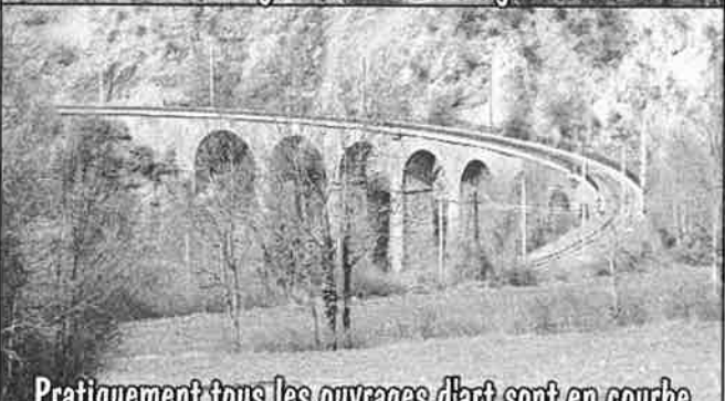
Nombreux ouvrages d'art sur une ligne de 30 km
